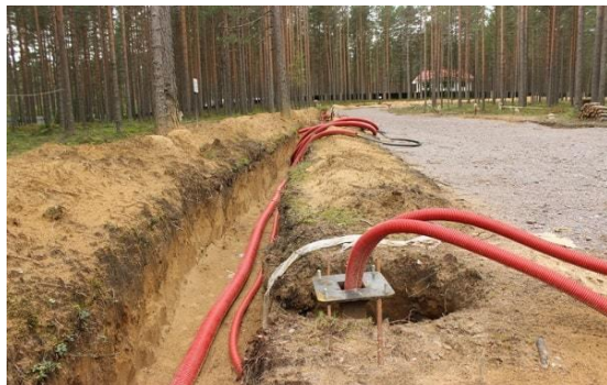
1. Прокладка провода под землей
